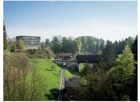
Alte Holzbrücke in Rothenburg
